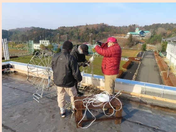
イルミネーションの取付作業
